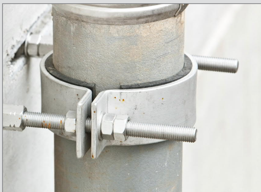
Bevestiging van aanvoer-/afvoerleidingen
