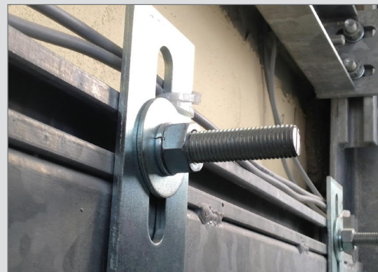
bevestiging van liftgeleiderdeuren in een schacht
