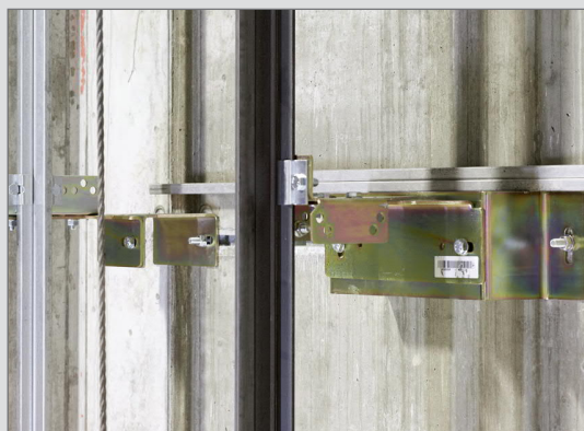
Bevestiging van liftschachtgeleiders
