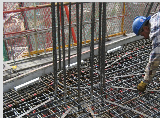
eenvoudige montage van JORDAHL® ponswapening JDA
