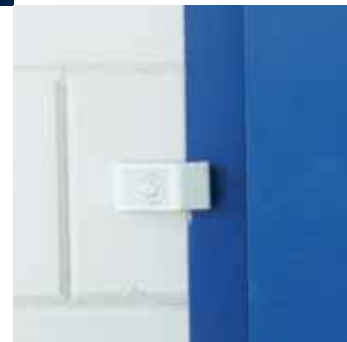
Toepassing verankering van een brandwand met kunststof smeltanker.
