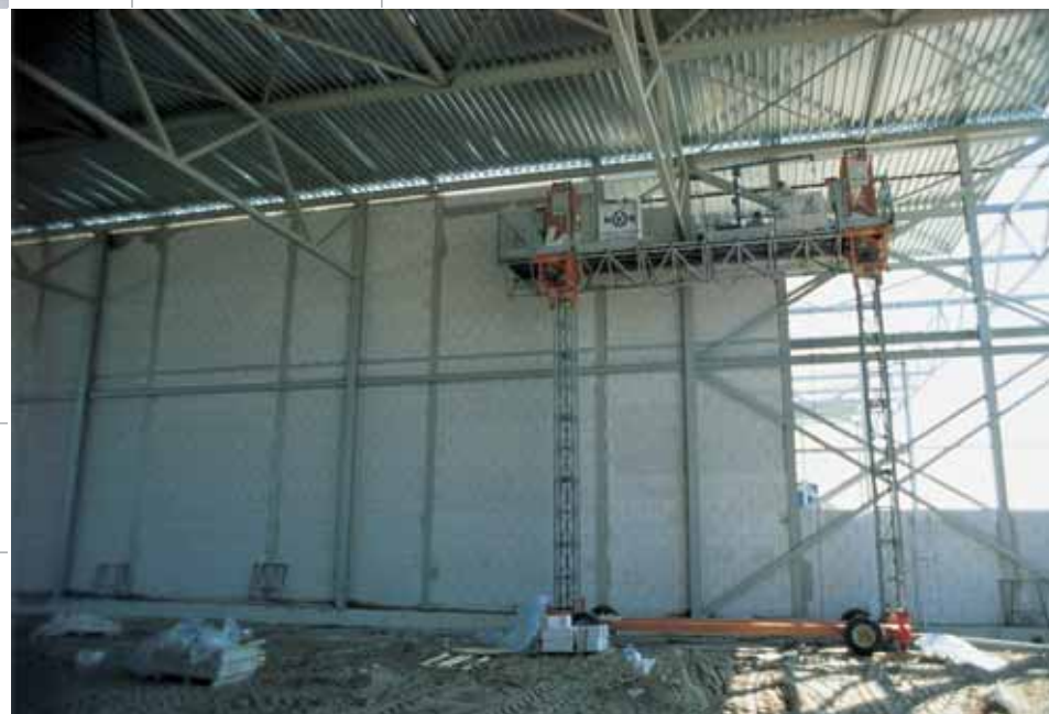
Hoge brandwand tussen dubbele kolommenrij geplaatst m.b.v. hoge HEK steiger.
