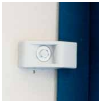
Detailfoto van verankering van brandwand tegen kolom m.b.v. kunststof smeltanker.
