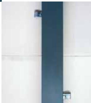
Om en om geplaatste stalen smeltankers.
