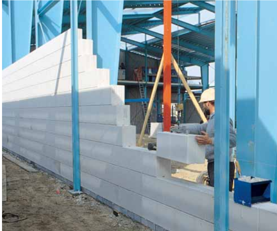
Wand tussen dubbele kolommenrij uitgevoerd in kalkzandsteen vellingblokken, machinaal verwerkt.
